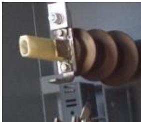
**Bild 6** Eingebaute Löschkammer in einem Mittelspannungs-Schaltfeld
